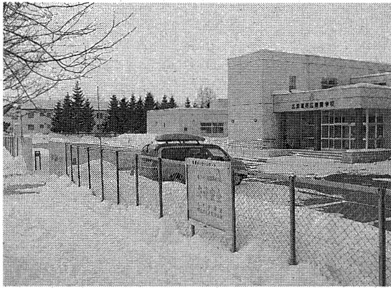
左奥の職員住宅を解体し、校舎棟を増築する
