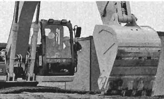
説明を受けながらバックホーを操作した
